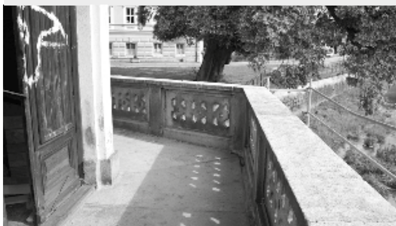
Takto restaurátoři opravili kamenné ohrazení. Předtím chyběla část vrchní desky. Někdo ji urazil, ta spadla do řeky a rozlomila se
