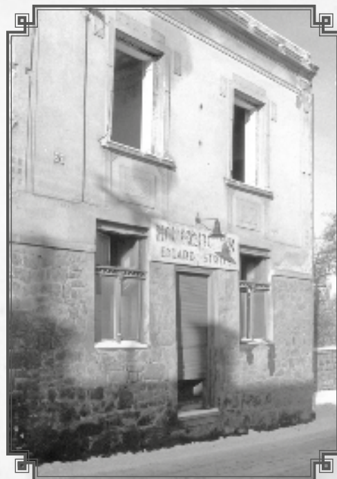
Pod Rejzkovou hospodou měl ofcinu holič Štros. Vchod byl přímo z ulice (připraveno k demolici)
