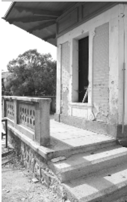
Celková oprava kamenného ohrazení těsně před dokončením. Na rekonstrukci ještě čeká fasáda altánu
