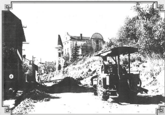
Výstavba nové Nádražní ulice
