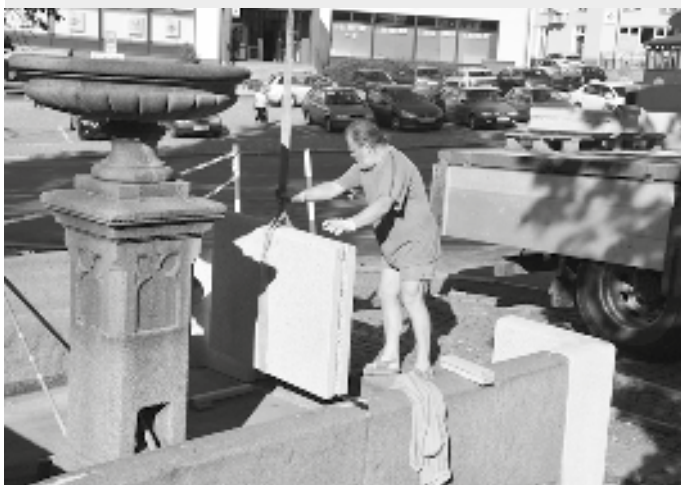
Usazování nových dílů zhotovených ze žuly
