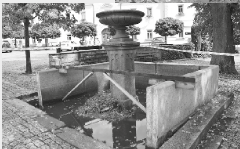
Kašna po demontáži čelních dílů nádrže
