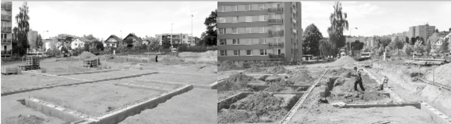
Základy budoucích domů komunitního bydlení v ulici Na Sídlišti
