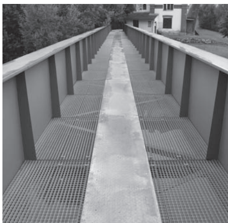
Ocelová lávka má již středový pás pro bezpečnější chůzi.
