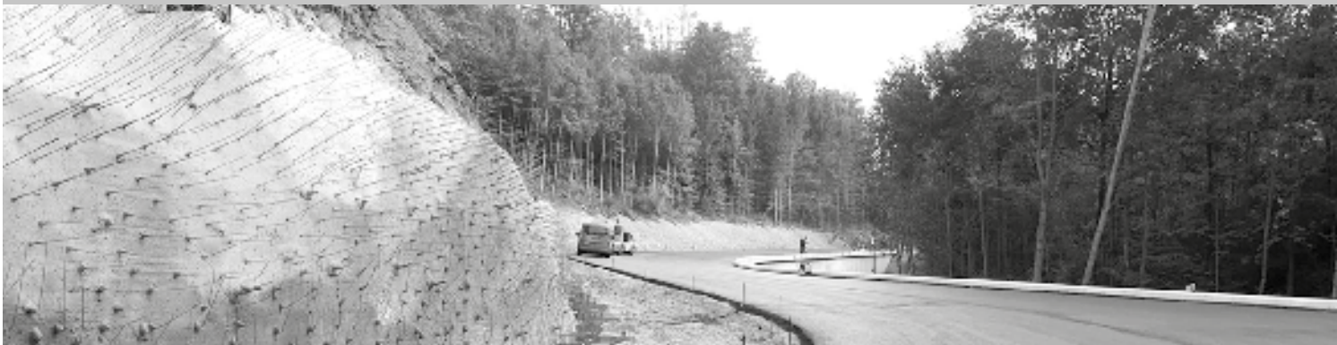
Opravovaný úsek silnice II/130 z Ledče do Hradce
