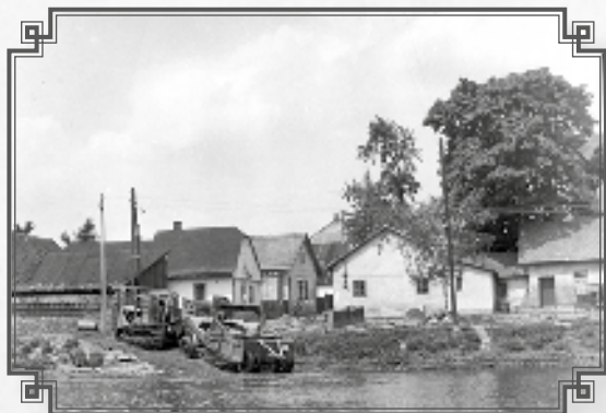
Pracovní stroje – nájezd z Jelenovy ul.
