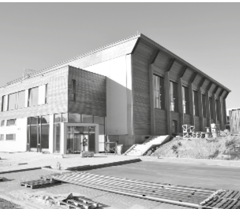
Pohled na halu od Komenského ulice
