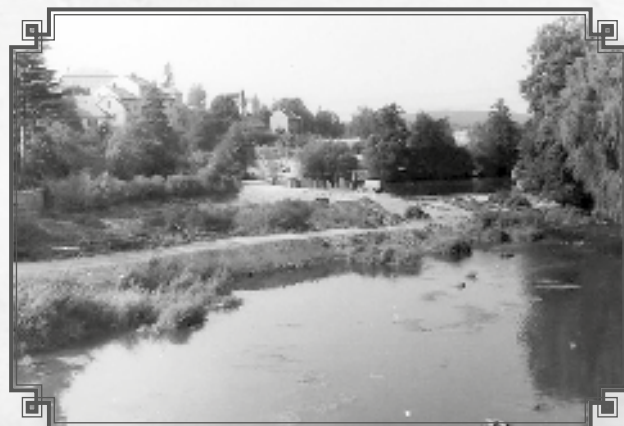
Provizorní cesta pro opravu
