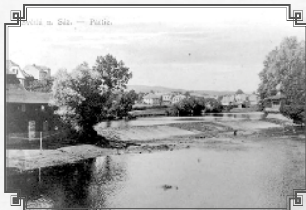
Jez před rekonstrukcí
