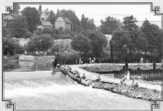
První polovina jezu uzavřena
