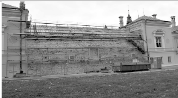
Stěna severního křídla zámku s částí zdi zimní zahrady s pěti objevenými okny
