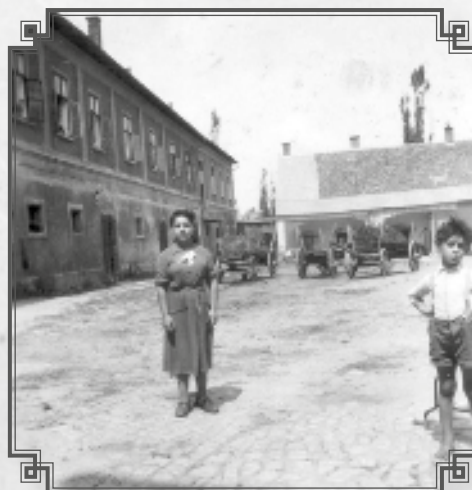
Vlevo budova s byty a nájemníci
