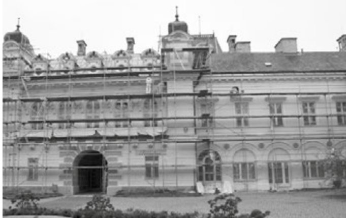
Malíři a štukatéri na lešení při opravě barokní fasády východního křídla zámku
