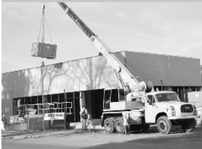
V době uzávěrky vánočního čísla SZ stavbaři dokončovali opláštění objektu Billy
