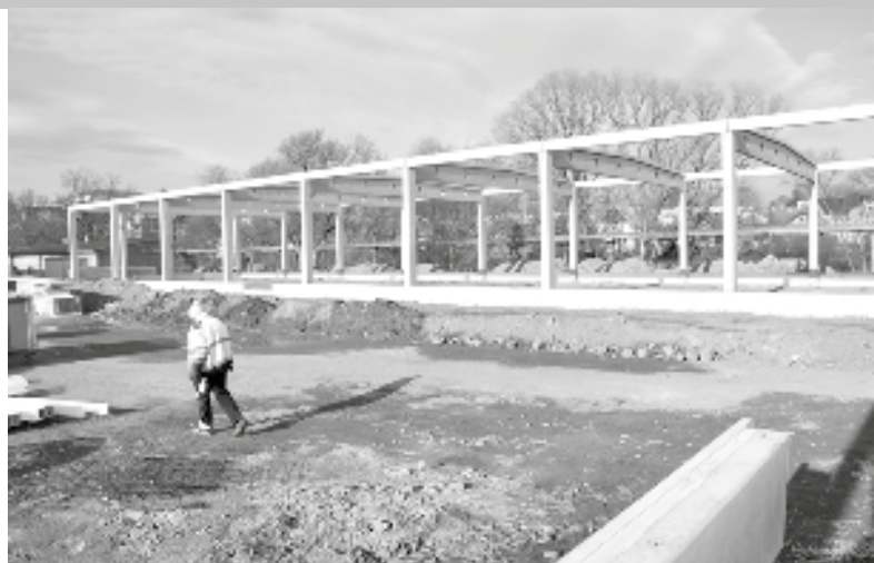
Majestátně vyhlíží 6 metrů vysoká konstrukce skeletu objektu prodejny KIK
