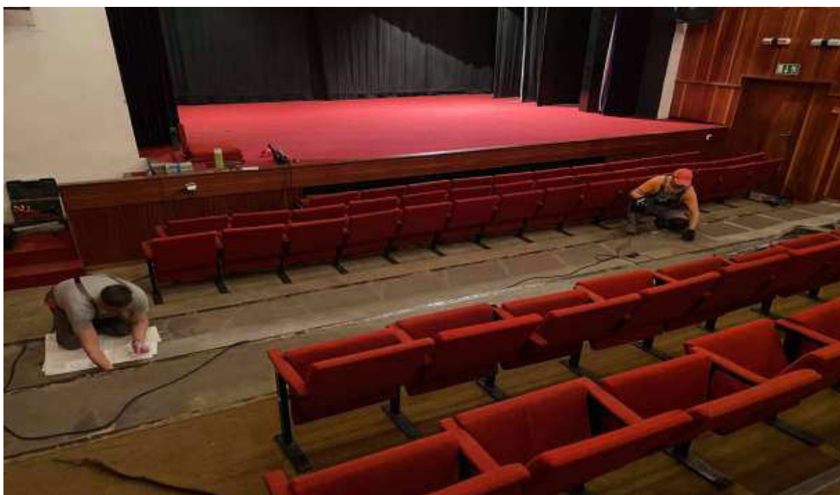
Rekonstrukce divadelního sálu
