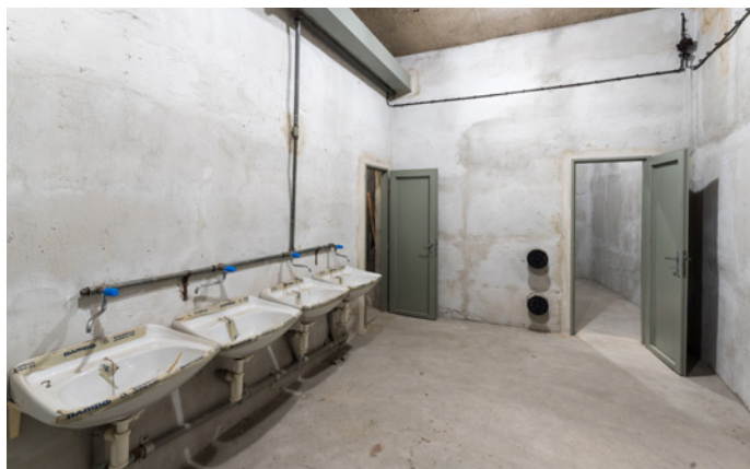
Pánské umývárny — ty jsou ukryté za „dřevěným“ ostěním sálu.
