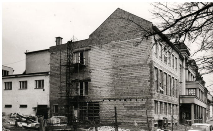
1983 — přístavba provozní budovy | Archiv Prácheňského muzea
