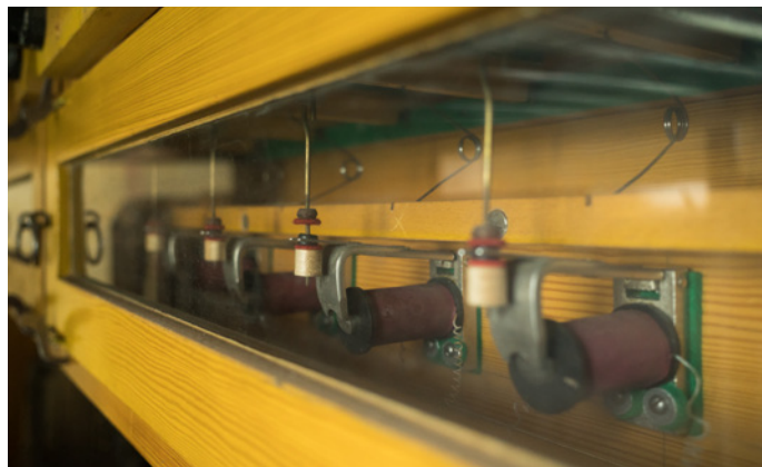
Elektromagnety ovládající ventily.
