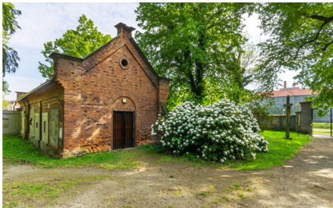
Bývalá márnice. V části jsou veřejné WC, v části zázemí...
