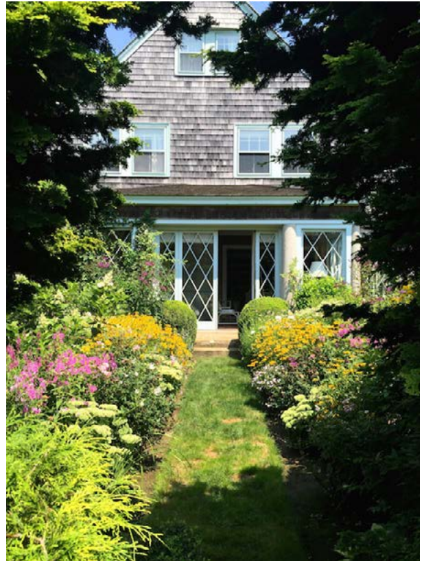
Súčasný stav domu. Foto: © Stacey Bewkes pre portál Quintessence
